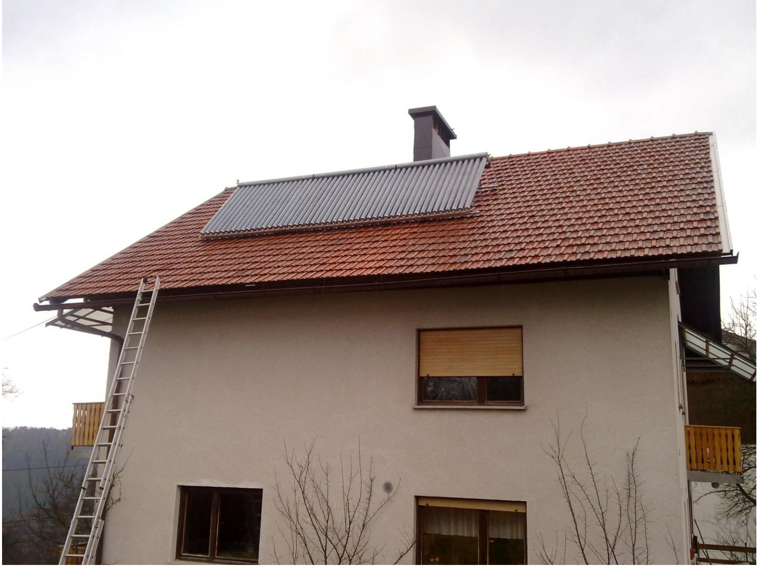
Solarni sprejemniki Greenland Systems za ogrevanje objekta in sanitarne vode: 3 x GL100 16 PT-S 11,40m 2
