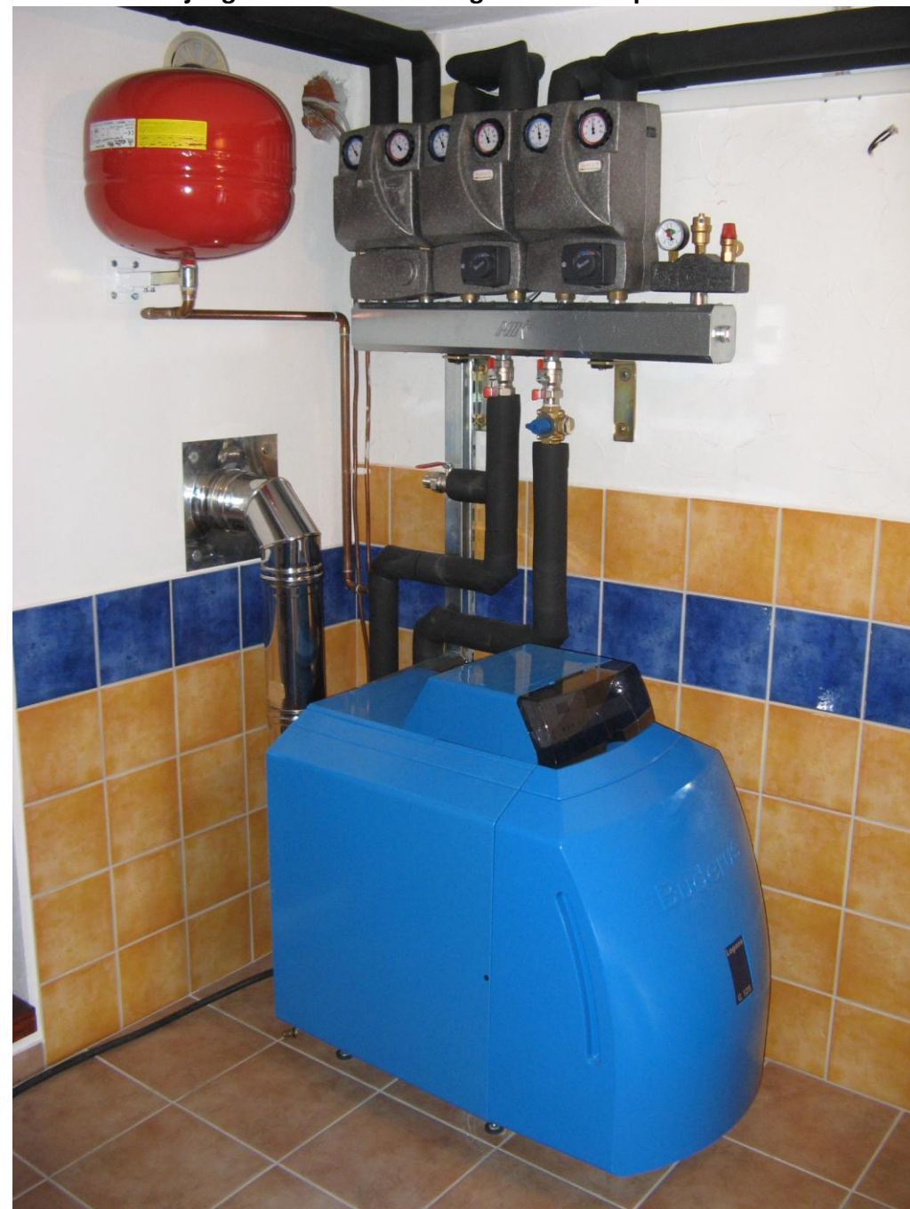
Po montaži Oljnega kotla BUDERUS Logano – modri plamen:
